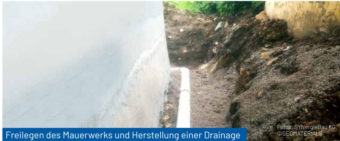
Freilegen des Mauerwerks und Herstellung einer Drainage
