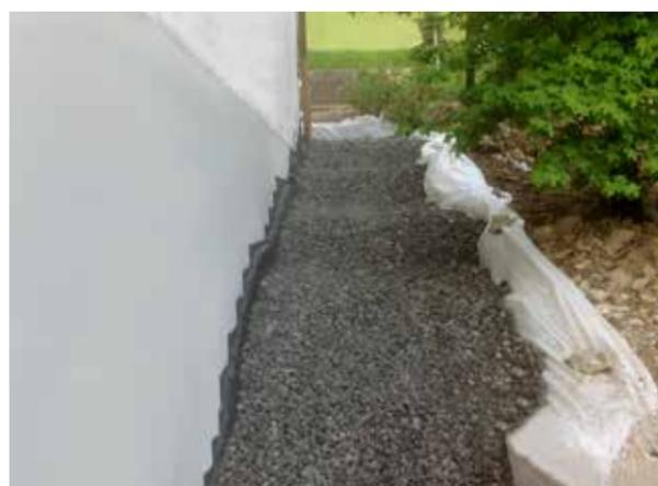
Alte und feuchte Wände benötigen einen kontrollierten Feuchte-Austausch. Neben der Herstellung einer funktionierenden Drainage ist die Hinterfüllung mit **GEOMATERIALS Schaumglas** eine geeignete Maßnahme zur Trockenlegung von Wänden.
