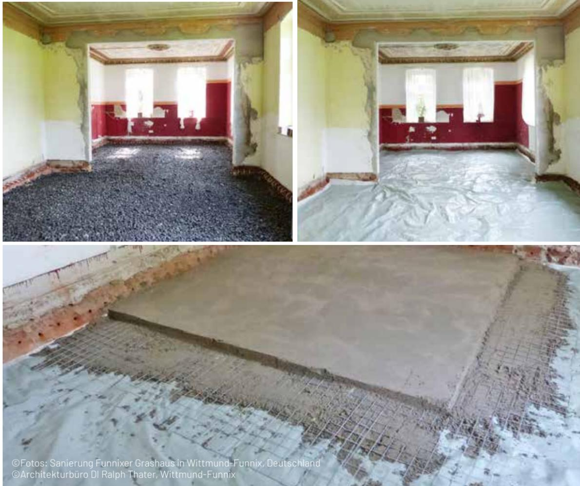
Mit **GEOMATERIALS Schaumglas** lässt sich eine deutlich geringere Aufbauhöhe realisieren. Durch den systematischen Aufbau mit z. B. 30 cm **GEOMATERIALS Schaumglas** im verdichteten Zustand erreichen Sie einen optimalen Fußbodenaufbau in Kombination mit einer nachfolgenden Estrichschicht.
