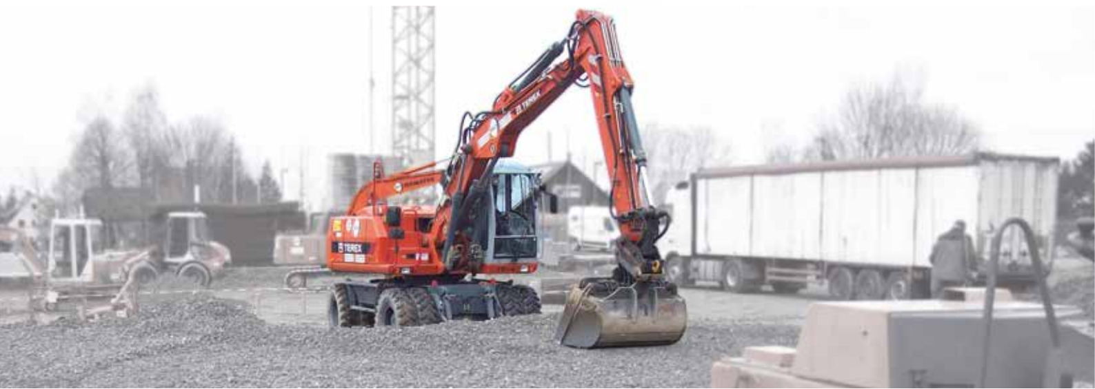
Großflächiger Einbau von GEOMATERIALS Schaumglas für eine Produktionshalle
