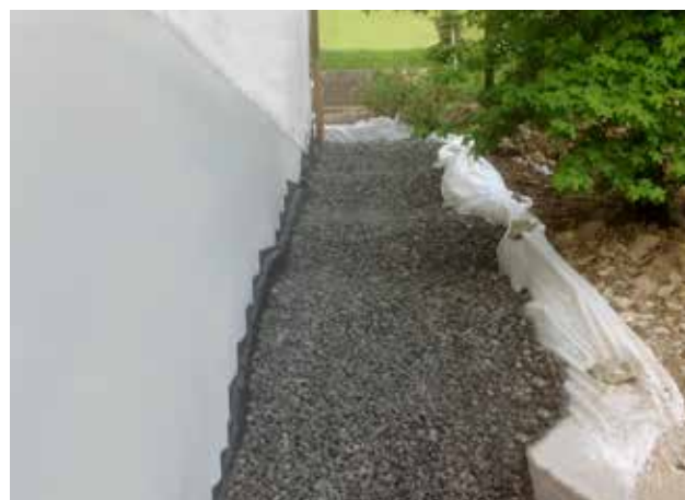
Auffüllen des Arbeitsgrabens und lagenweise Verdichten von GEOMATERIALS Schaumglas
