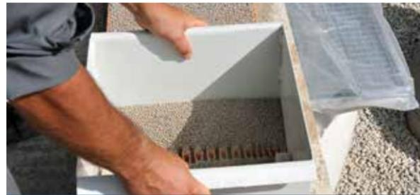
Mittels Granulatschlitten, der über die Ziegeln geschoben wird, erfolgt das Verfüllen mühelos.
