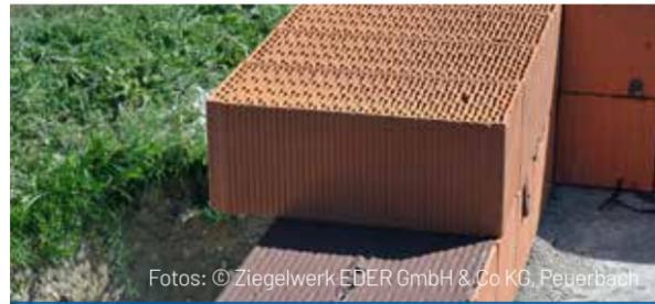
Der Deckenmörtel kann nach Freifegen der Ziegel wie gewohnt aufgetragen werden.
