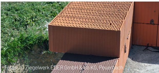
Der Deckenmörtel kann nach Freifegen der Ziegel wie gewohnt aufgetragen werden.
