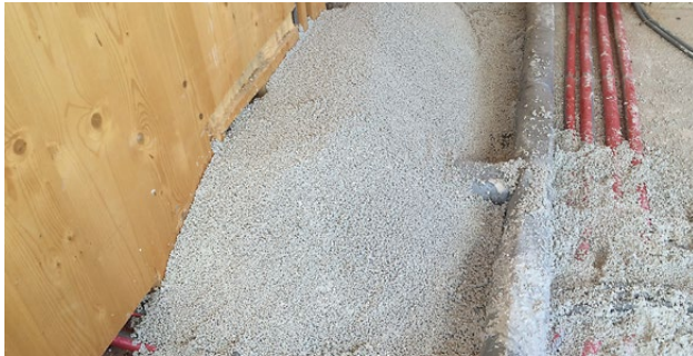
2. Schritt GEOMATERIALS Blähglas überdeckt alle Installationsleitungen
