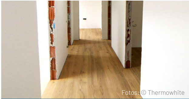
8. Schritt - Bodenverlegung abschließend wird der gewünschte Fussboden verlegt
