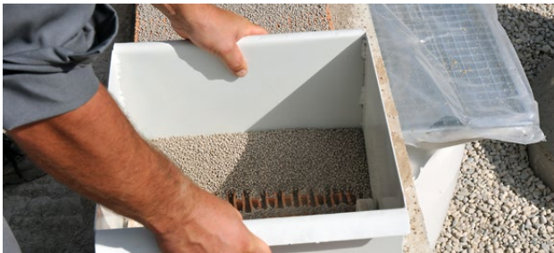
Mittels Granulatschlitten, der über die Ziegeln geschoben wird, erfolgt das Verfüllen mühelos.
