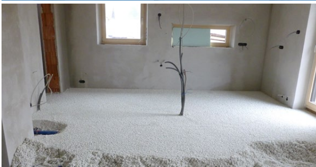
3. Schritt - Dämmschüttung einbauen planieren und auf das vorhergesehene Niveau abziehen
