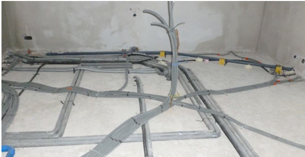
1. Schritt - Rohinstallation Abgeschlossene Installationsarbeiten vor der Wärmedämmung
