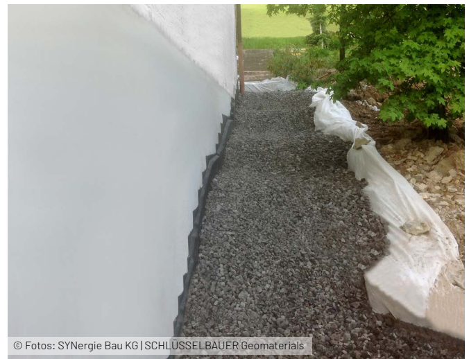
Auffüllen des Arbeitsgrabens und lagenweise Verdichten von GEOMATERIALS Schaumglas | © Fotos: SYnergie Bau KG | SCHLÜSSELBAUER Geomaterials
