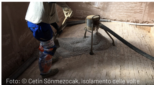
Foto: © Cetin Sönmezocak, isolamento delle volte
