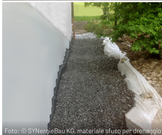
Foto: © SYnergieBau KG, materiale sfuso per drenaggio
