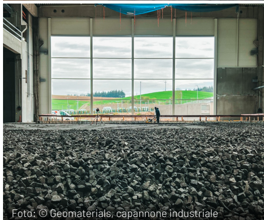
Foto: © Geomaterials, capannone industriale
