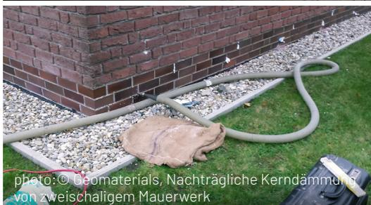
photo: © Geomaterials, Nachträgliche Kerndämmung von zweischaligem Mauerwerk
